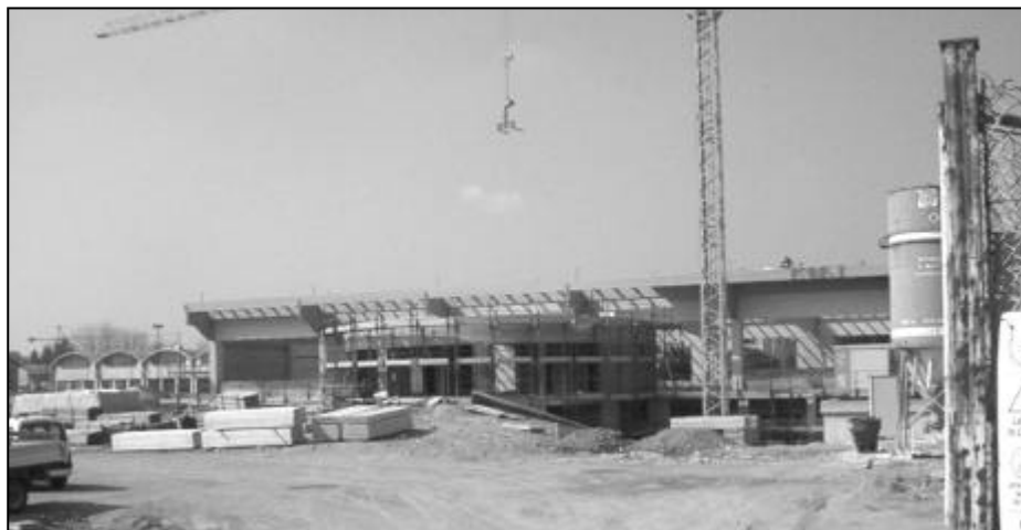
Il cantiere per la costruzione dell'impianto sportivo polivalente
